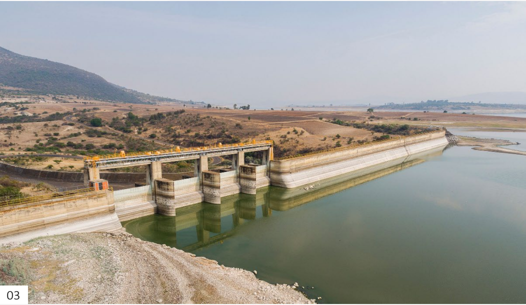
1 - CENTRALE NECAXA, FÉNIX – MEXIQUE 2 - CENTRALE LERMA, FÉNIX – MEXIQUE 3 - CENTRALE LERMA, FÉNIX – MEXIQUE
