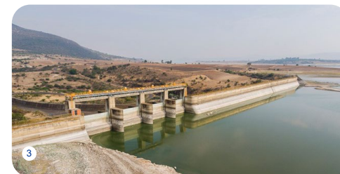
1 - CENTRALE NECAXA, FÉNIX – MEXIQUE 2 - CENTRALE LERMA, FÉNIX – MEXIQUE 3 - CENTRALE LERMA, FÉNIX – MEXIQUE
