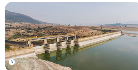
1 - CENTRAL NECAXA, FÉNIX - MÉXICO 2 - CENTRAL LERMA, FÉNIX - MÉXICO 3 - CENTRAL LERMA, FÉNIX - MÉXICO
